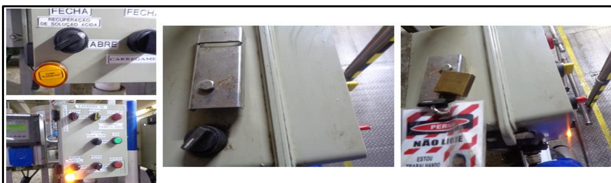
Figura 24 – Instalação de bloqueio de energia
